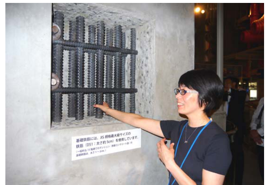
写真 4 (国内の規格品で最も太い51mmφの鉄筋を使用。奥脇さんの指が廻らない太さ。)
