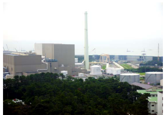
写真 5(施設構内の遠景。海との堺にあるのが防波壁。)
