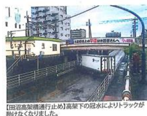
【田沼高架橋通行止め】高架下の冠水によりトラックが動けなくなりました。
